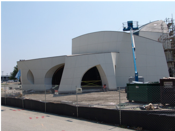
Bau der Interfaith Peace Chapel auf dem Campus der Cathedral Of Hope in Dallas, Texas
